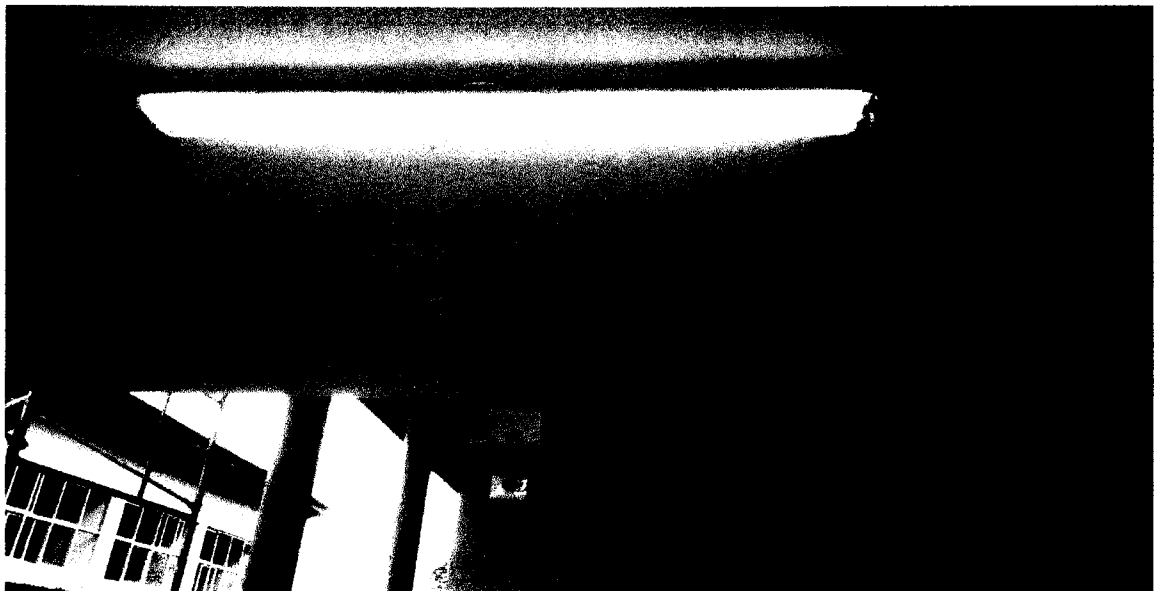
VISTA DE TRABAJOS ELECTRICOS REALIZADOS EN OBRA.
