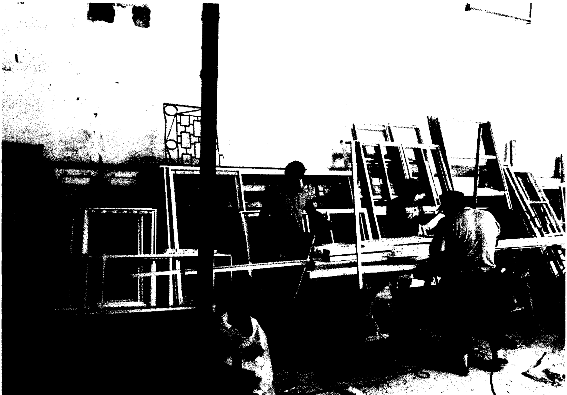
VISTA DE RESIDENTE VERIFICANDO LA CARPINTERIA METALICA.
