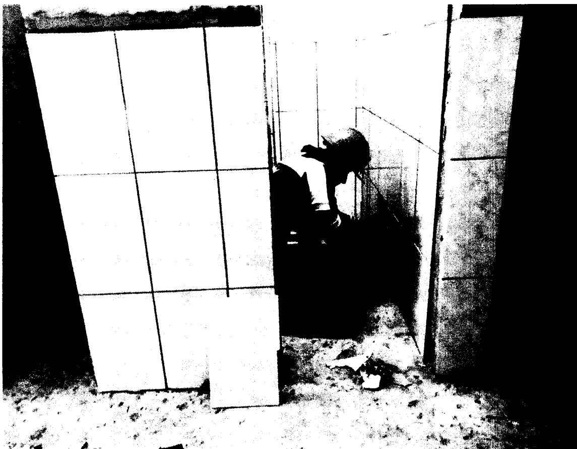
VISTA DE COLOCACION DE CERAMICOS EN PISO Y PARED
