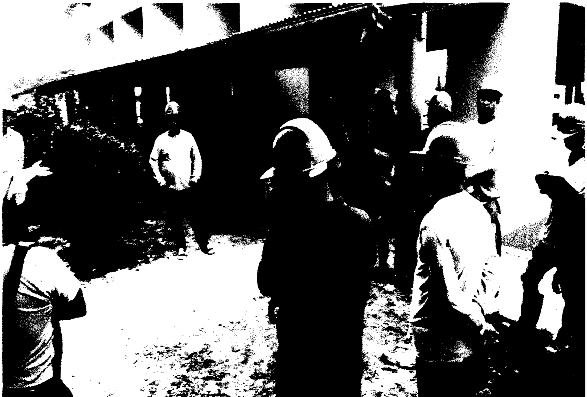
VISTA DE LAS CHARLAS DE SEGURIDAD EN OBRA.
